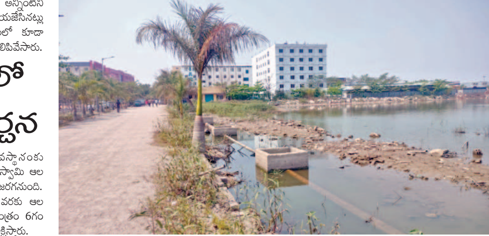
దుండిగల్ చిన్నదామర చెరువులో ఏరోనాటికల్ కాతేజ్ యాజమాన్యం నిర్మించిన కట్టడాలు
